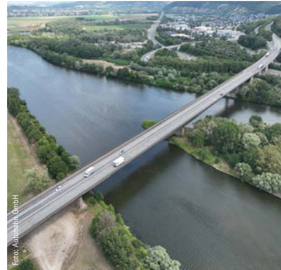
Die Moselbrücke bei Trier-Ehrang ist sanierungsbedürftig.
