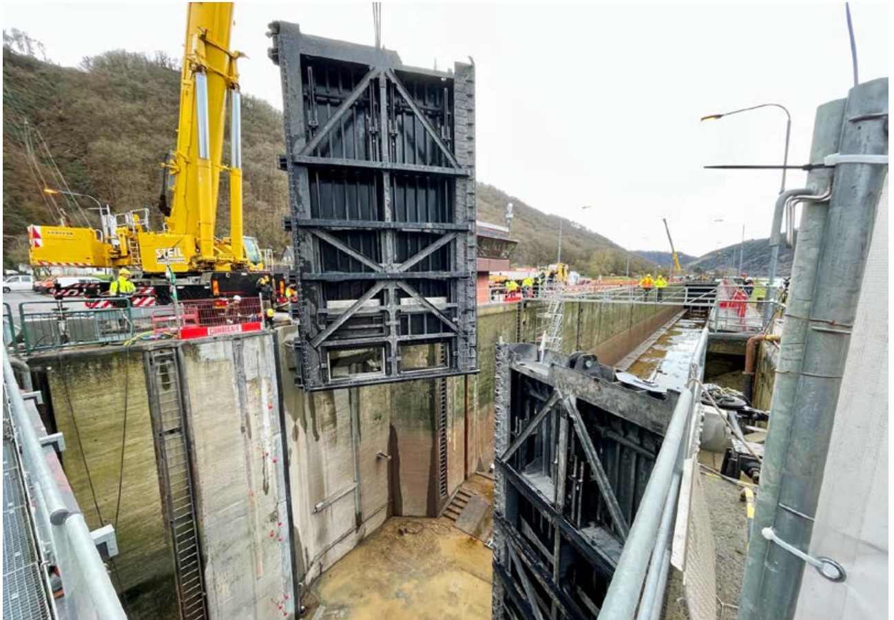
Mit einem Spezialkran der Trierer Firma Steil wird ein neuer Torflügel der Moselschleuse in Müden eingesetzt.
