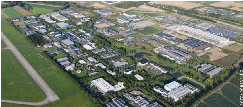
Blick aus der Vogelperspektive auf den Industriepark Region Trier in Föhren und Hetzerath: Die beiden Wirtschaftskammern der Region haben ein gemeinsames Positionspapier veröffentlicht.
