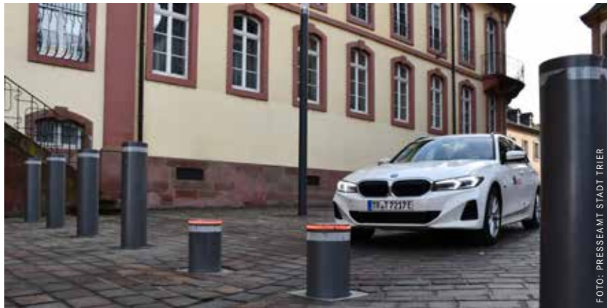
Die neuen Sicherheitspoller am Trierer Domfreihof gehen am 4. März in den Testbetrieb.
