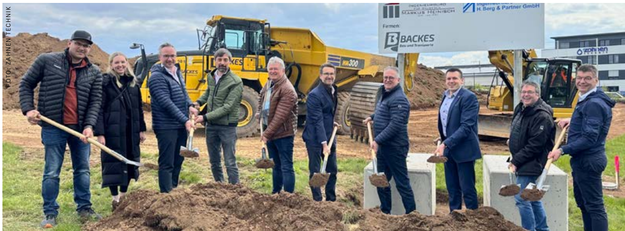
Bei Zahnen Technik entstehen ein neues Bürogebäude, eine Produktionshalle sowie überdachte Parkplätze mit Solarmodulen und E-Ladestationen.
